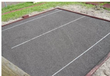
Drainbeton/Splitt eben abziehen
