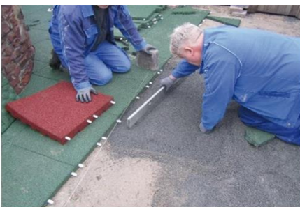
Verlegung von Outdoorplatten
