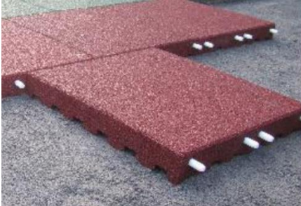
Verlegung auf Splitt
