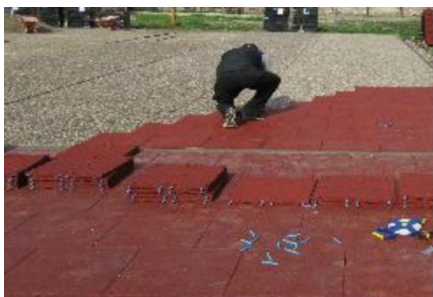
Verlegung von Outdoorplatten
