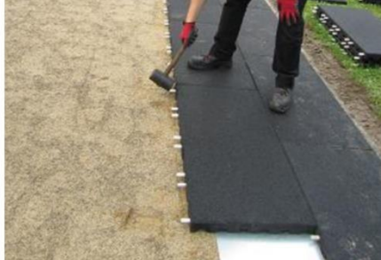
Einsatz eines Blechs
