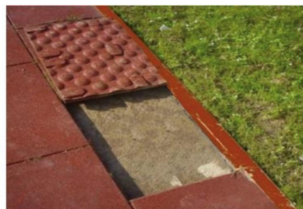
Platten mit Rasenkanteneinfassung
