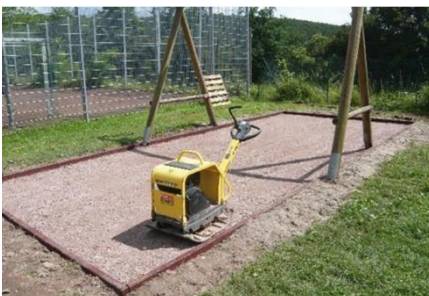
Schotter/Frostschutz standfest verdichten
