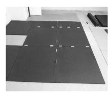
Der Belag wird auf dem vorbereiteten Untergrund mit einer Fixierung für PVC- und Gummibeläge (z. B. Thomsit TK 199) fixiert. Die Fixierung wird auf den auf den Untergrund aufgerollt. Die Platten werden nach oberflächlicher Antrocknung der Fixierung eingelegt und sorgfältig angedrückt. Der Verbrauch ist abhängig von der Saugfähigkeit des Untergrunds und beträgt bei nicht saugenden Unterböden (Schaumrolle) ca. 100 g/m² und bei gespachtelten Unterböden (kurzhaarige Lammfellrolle) ca. 150 g/m².
