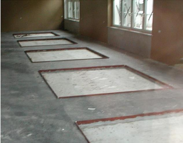
Bauseits wird in den Estrich ein Rahmen aus Winkelprofilen durch einen Estrichleger eingebaut.
