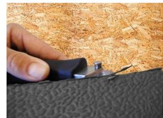
Zum Toleranzausgleich kann ggf. mit dünnen PVC-Streifen im Nahtbereich untergelegt werden, um einen sauberen Übergang von Platte zu Platte zu erzielen (Bilder 1,2 und 3). Ggf. verwenden Sie eine andere Platte an dieser Position. Vulkanisationsüberstände an der Plattenoberkante werden vor der Verlegung abgeschnitten (Bild 4). Die eingepassten Stemmbodenplatten werden mit Dispersionsklebstoff z. B. Thomsit K 188 E vollflächig verklebt.
