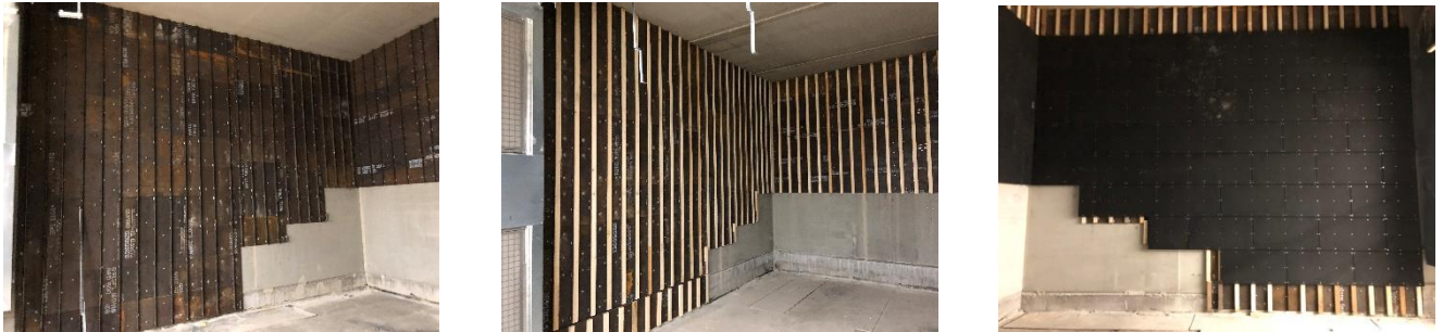
Bild 1: Metall-Laschen werden auf die Stahlplatten im Achsmaß von 24,9 cm montiert.
