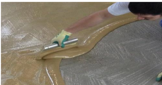
Klebstoffauftrag mit Zahnpachtel.
