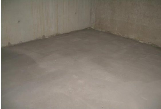
Unterbodenvorbereitung durch Spachteln.
