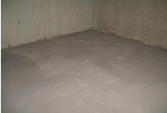
Unterbodenvorbereitung durch Spachteln.
