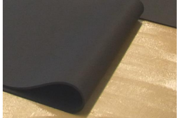
Einlegen der Elastikschicht in den Klebstoff.
