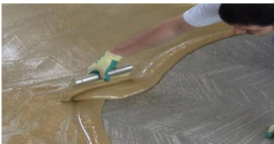
Klebstoffauftrag mit Zahnpachtel.
