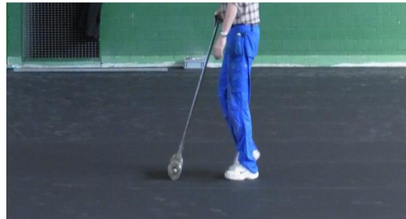
Anreiben oder Anwalzen der Elastikschicht mit einer Linoleumwalze.
