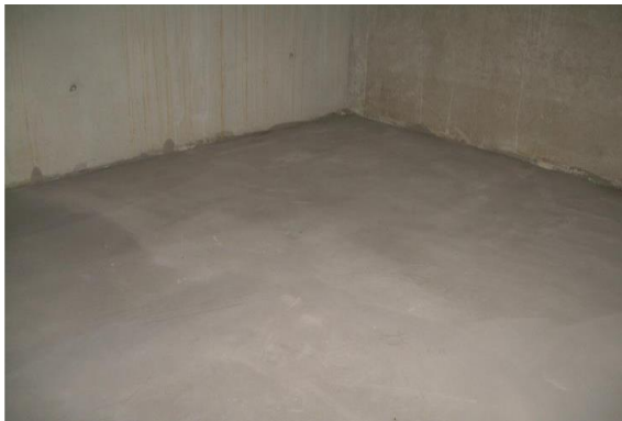
Unterbodenvorbereitung durch Spachteln.
