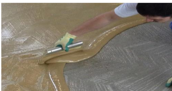
Klebstoffauftrag mit Zahnspachtel.
