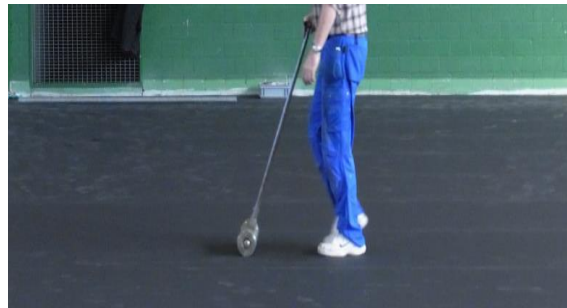
Anreiben des Belags o. Anwalzen mit einer Linoleumwalze.
