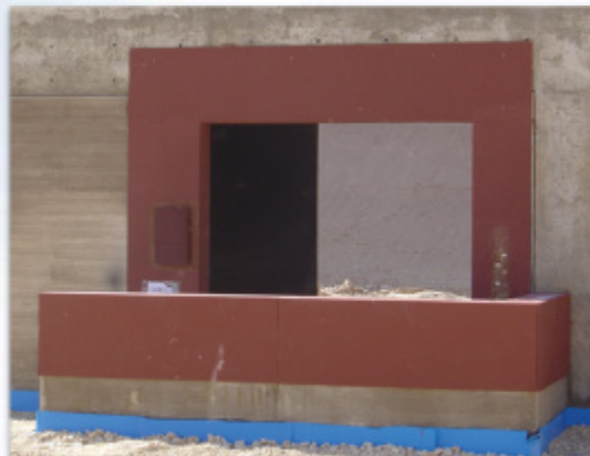
Ballistischer Stahl HB500 als Bauwerksabsicherung
