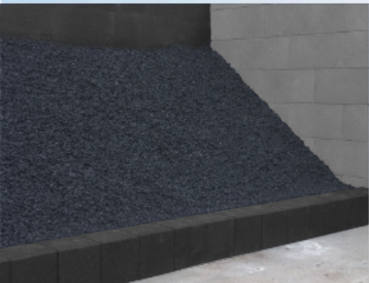
Seitenverkleidung Geschossfangkammer
