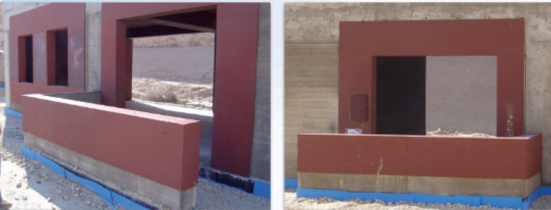
Ballistischer Stahl HB500 als Bauwerksabsicherung
