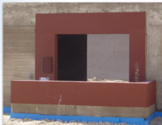
Ballistischer Stahl HB500 als Bauwerksabsicherung
