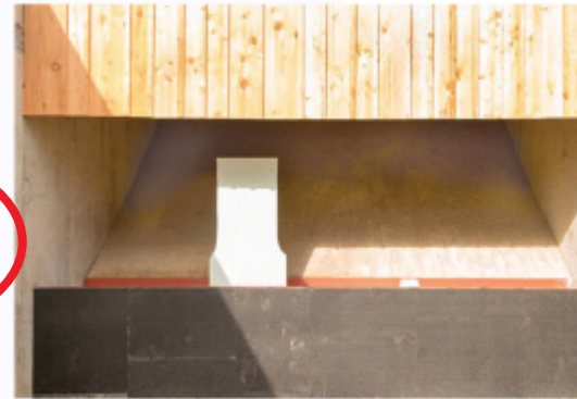
Rückprallschutz 30 mm montiert auf splitterfreier Montageleiste
