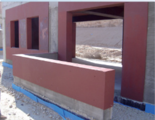
Ballistischer Stahl HB500 als Bauwerksabsicherung
