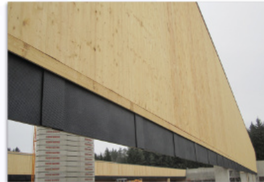
Durch den Abstandshalter ist ein korrekter Sicherheitsabstand zwischen Stahlplatte und Splitterschutzlamelle gewährleistet
