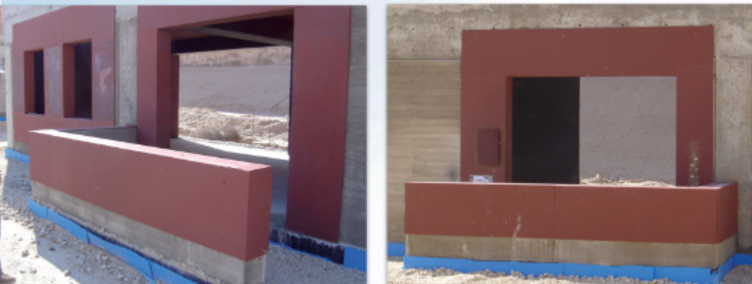
Ballistischer Stahl HB500 als Bauwerksabsicherung
