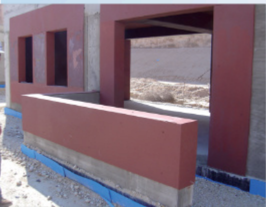
Ballistischer Stahl HB500 als Bauwerksabsicherung
