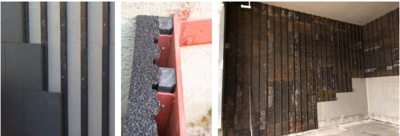
Beispielbilder: Unterkonstruktion aus SBQ-Montageleisten auf Beton und auf Stahluntergrund.
